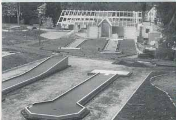
Die „heiße“ Bauphase des Bahnengolfzentrums in Bad Münster
