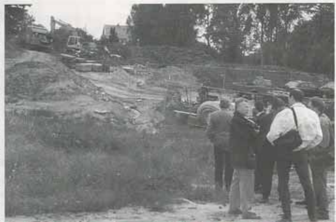
Noch eine Baustelle - Das Gelände für das Minigolfzentrum
